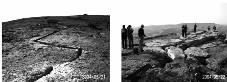
图5 典型的构造-燃烧裂隙和构造-塌陷-燃烧裂隙
