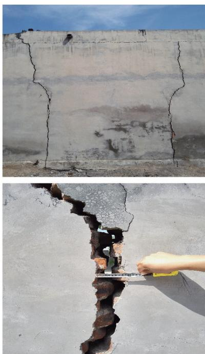
图 18 断层露头处民房损坏情况
