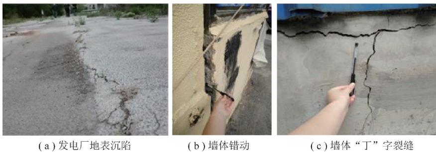
图 7 距北帮 100~500 m 地质灾害及城区建筑物损害情况
