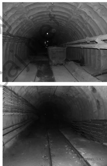
图 7 实施 U 型钢封闭支架 2 a 后的底板支护效果
