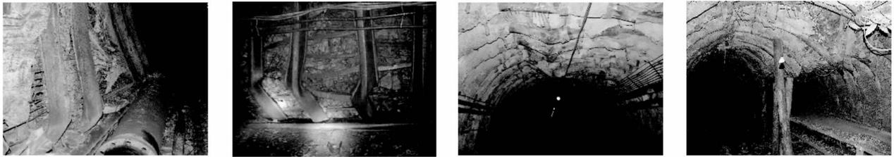
图 1 U 型钢拱形可缩支架破坏实例
