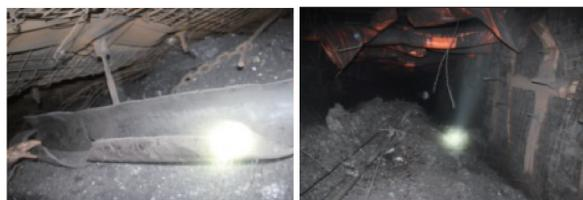
图 4 冲击地压事故现场照片
