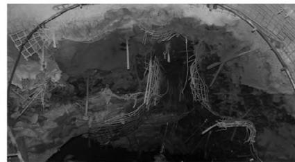
图 2 锚网索喷支护围岩破坏
